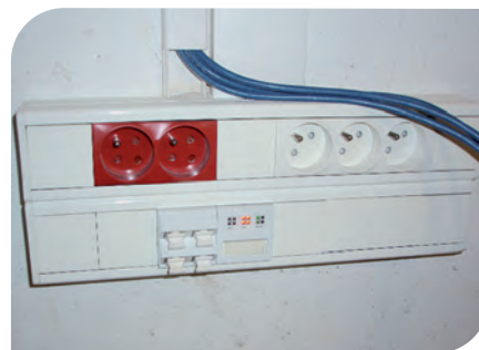
Figure 2. Micro-switch inséré dans une goulotte 45 mm x 45 mm avec 4 sorties et blocs de diodes de contrôle.
